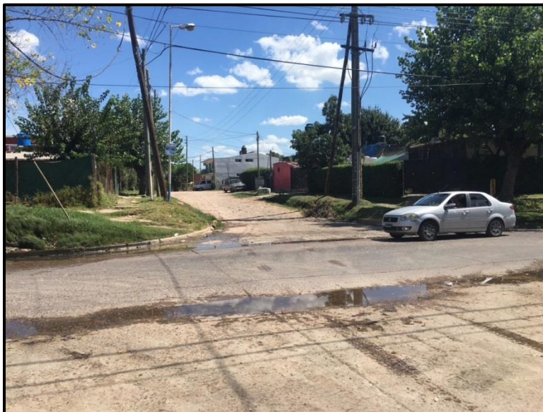
Imagen N° 2.45: Cruce de calle Bolivia y Av. Olivos, localidad de Grand Bourg. Coordenadas específicas: 34°27'47,93" S y 58°42'52,36" W.
