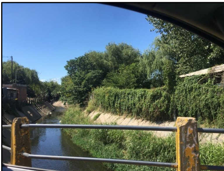
Imagen N° 2.46: Arroyo encauzado ubicado en el cruce de Av. Olivos y la calle Hooke, localidad de Grand Bourg. Coordenadas específicas: 34°27'56,34" S y 58°42'45,49" W.
