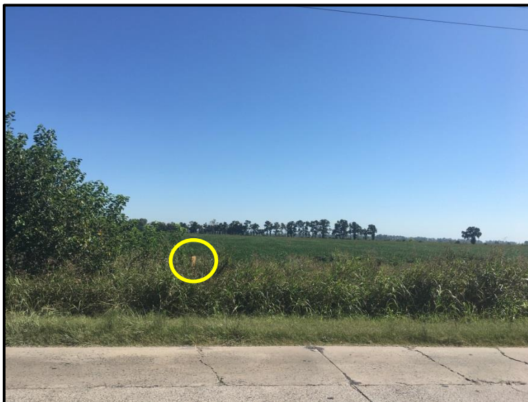
Imagen N° 2.6: Cruce del gasoducto con la ruta provincial N° 6. Se marca en amarillo el mojón correspondiente, que indica la ubicación exacta del gasoducto.
