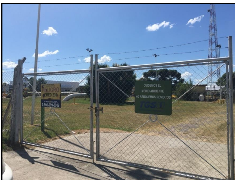
Imagen N° 2.52: Estación de Medición Pacheco EMED 239, ubicada sobre la Colectora Este Panamericana Ricardo Rojas. Este punto constituye el fin de la obra. Coordenadas geográficas: 34°28'18,11" S y 58°40'24,48" W.
