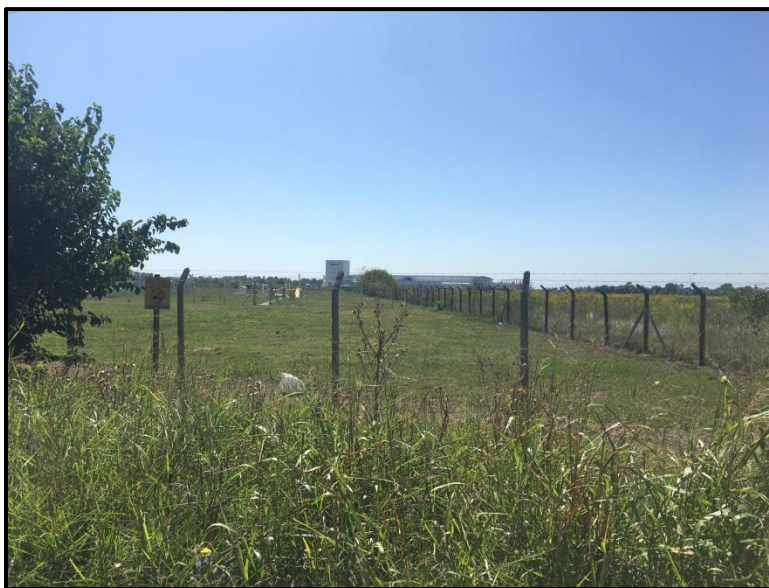
Imagen N° 2.12: Trampa en predio de TGN, desde aquí el gasoducto va hacia Planta Rodríguez.
