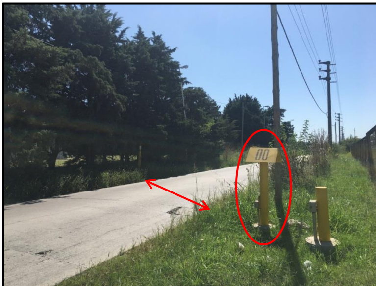
Imagen N° 2.16: Mojón 0 (marcado en rojo), salida de gasoducto desde Planta Rodríguez. El mismo cruza la ruta 24 y a partir de allí corre de forma paralela a la ruta 24.
