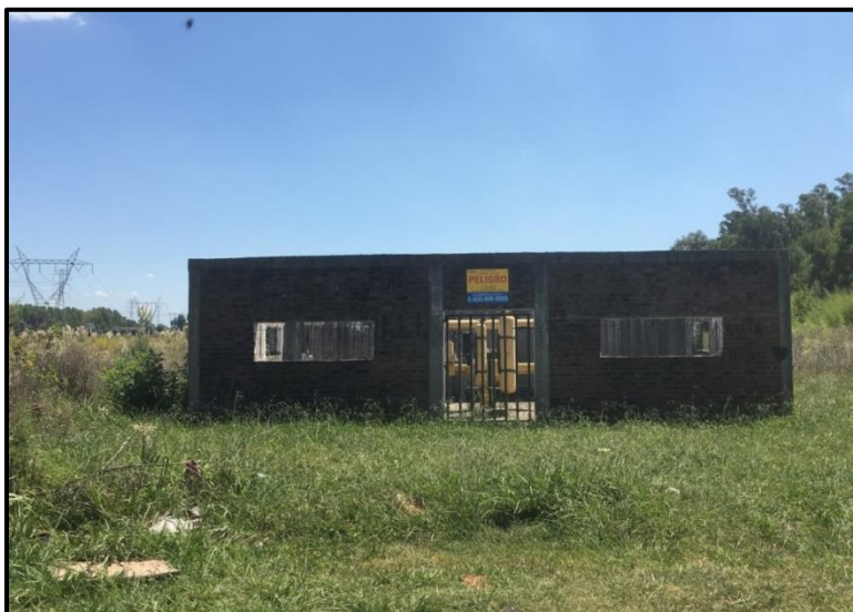
Imagen N° 2.27: Planta de Regulación LS-83, ubicada sobre Av. San Fernando. Las coordenadas geográficas específicas son: 34°33'39.72" S y 58°51'35.56" W.
