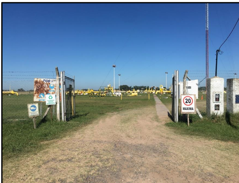
Imagen N° 2.1: Ingreso a Planta Las Heras. Coordenadas geográficas: 34°50'04,66" S y 59°00'50,20" W.
