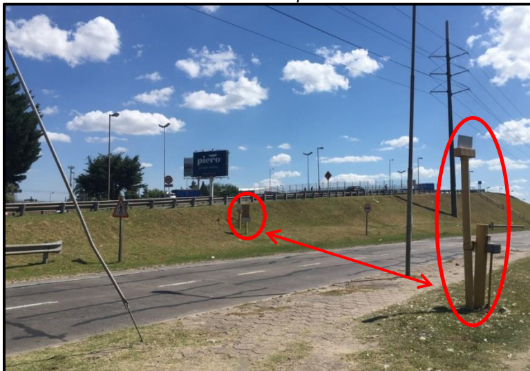
Imagen N° 2.50: Cruce del gasoducto con la colectora oeste de la Autopista Panamericana mano a Capital.
