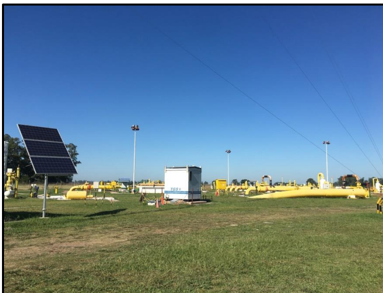
Imagen N° 2.2: Detalle de interior de Planta Las Heras.
